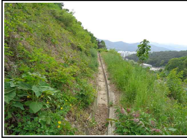
【그림 1.3.3】배수시설 전경
