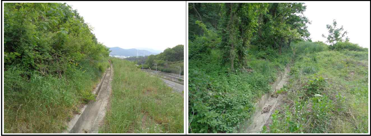
【그림 1.3.7】배수시설 전경
